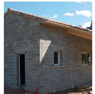
Les blocs béton, nouvelle génération,
